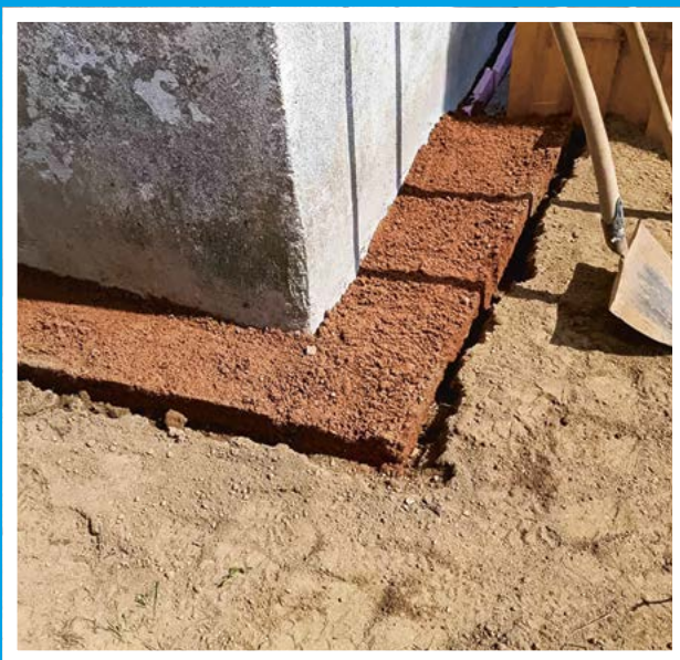
▲ Abdichtung von Fundamenten mit Lehm
