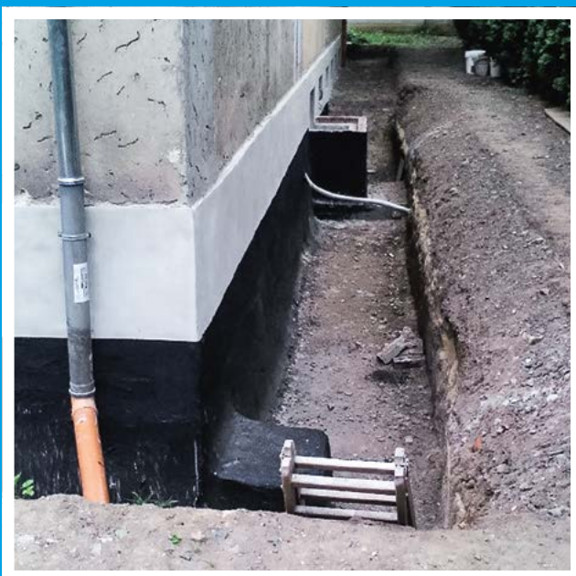
▲ Vertikale Abdichtungsarbeiten
