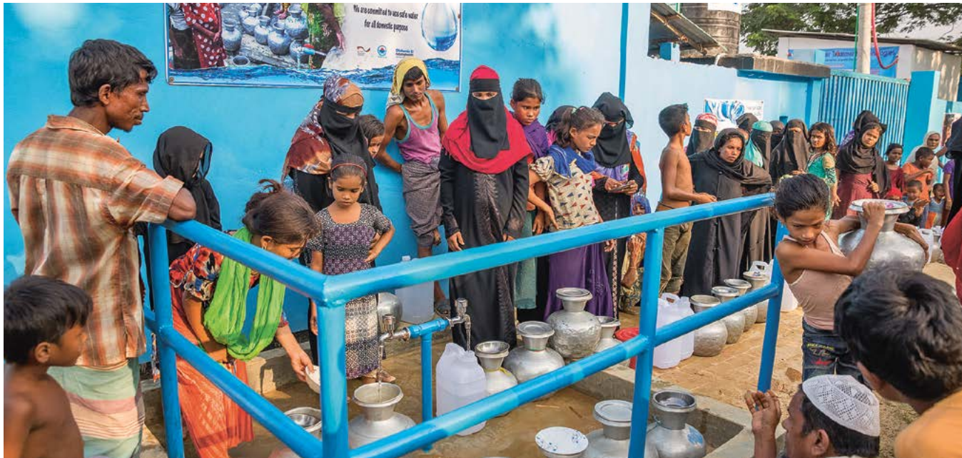
▲ Die Diakonie Katastrophenhilfe hat zusammen mit einer Partnerorganisation eine Meerwasser-Entsalzungsanlage gebaut.
