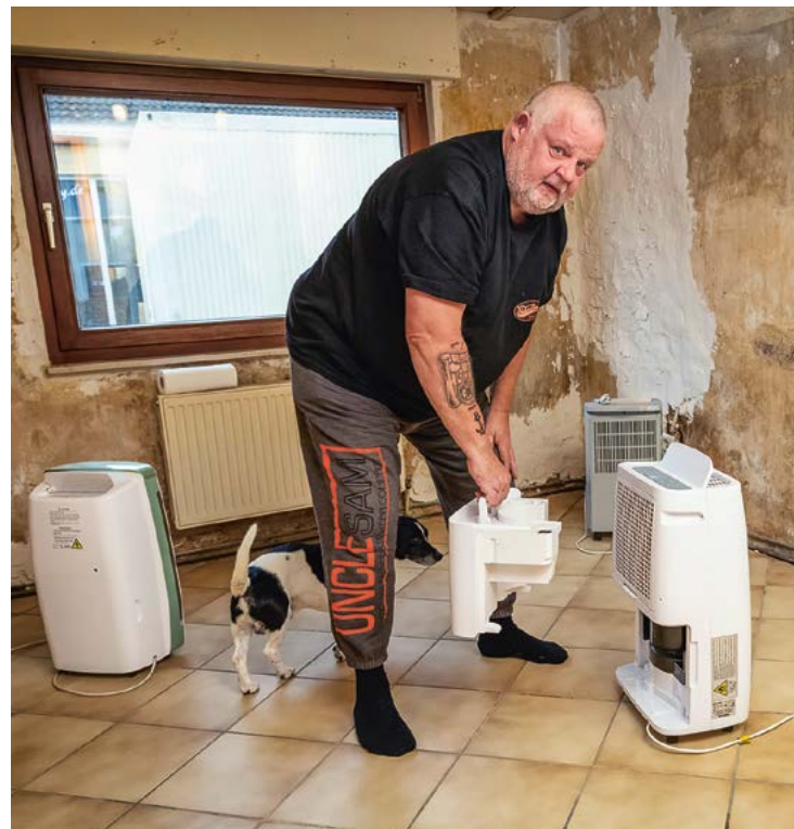
▲ Bei Hans-Jürgen Schmitz stand das Erdgeschoss komplett unter Wasser. Bautrockner sorgen dafür, dass das Haus wieder renoviert werden konnte
